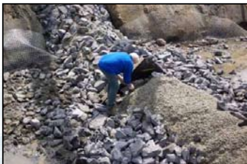
Figuur 5: Aanleg van stenen drempels in de v-vormige bekkentrap op de Kleine Nete in Herentals
